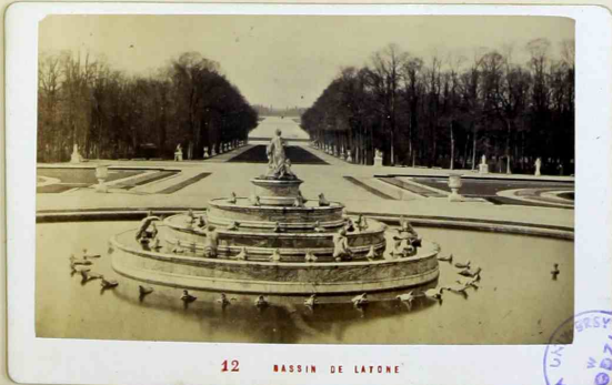
12 BASSIN DE LATONE
