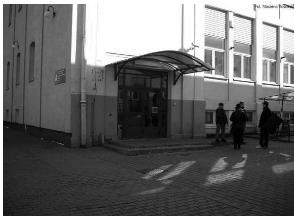
Fot. 3. Budynek Wyższej Szkoły Informatyki
