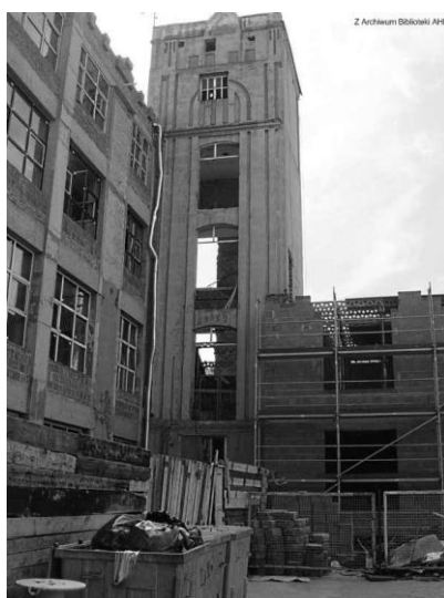
Fot. 5. Remont budynku Biblioteki Akademii Humanistyczno-Ekonomicznej
