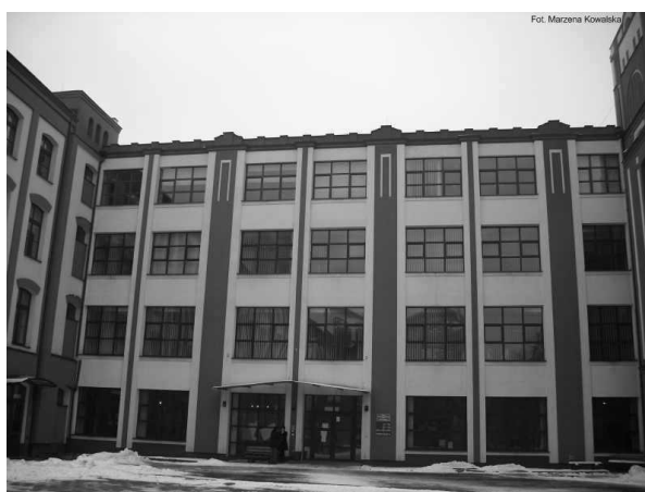
Fot. 6. Budynek Biblioteki Akademii Humanistyczno-Ekonomicznej po remoncie
