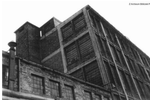
Fot. 9. Budynek Biblioteki Politechniki Łódzkiej przed remontem
