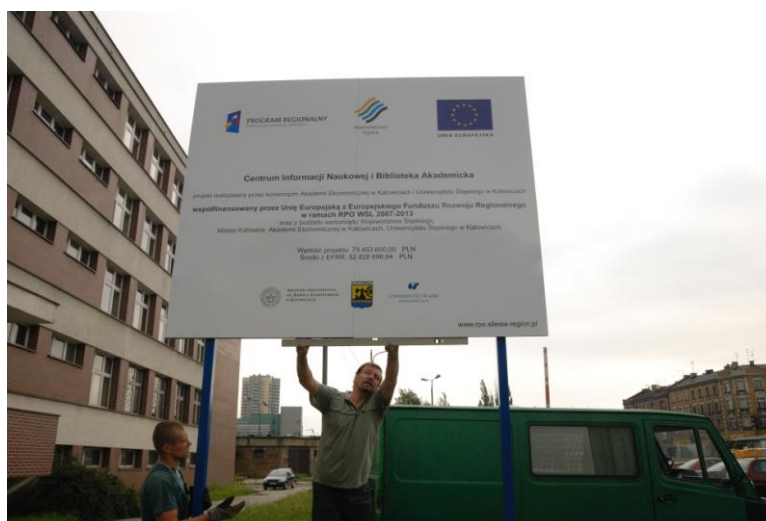
Fot. 1. Montaż tablicy informacyjnej przy terenie budowy (kampus Uniwersytetu Śląskiego, ul. Bankowa w Katowicach)
