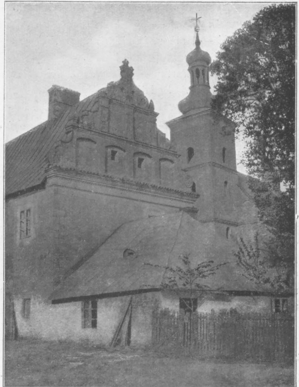
Wąglczew. Szczyt klasztoru zbudowanego około r. 1626 (fot. amat. H. Piekarskiego).
