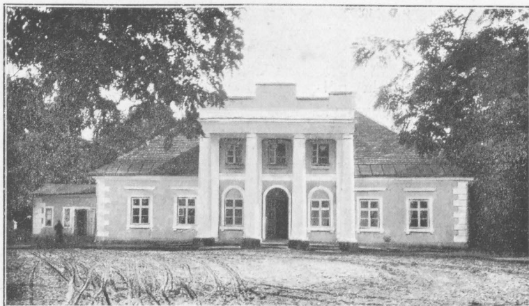
Dwór w Wrzącej Wielkiej od strony podjazdu.
