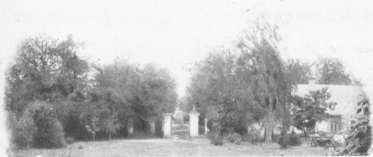
Wjazd do pałacu.
