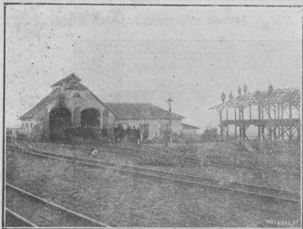
Remiza i warsztaty w budowie — Pińczów
