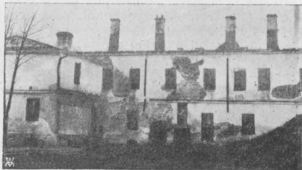
Pińsk — odbudowa spalonej szkoły realnej
