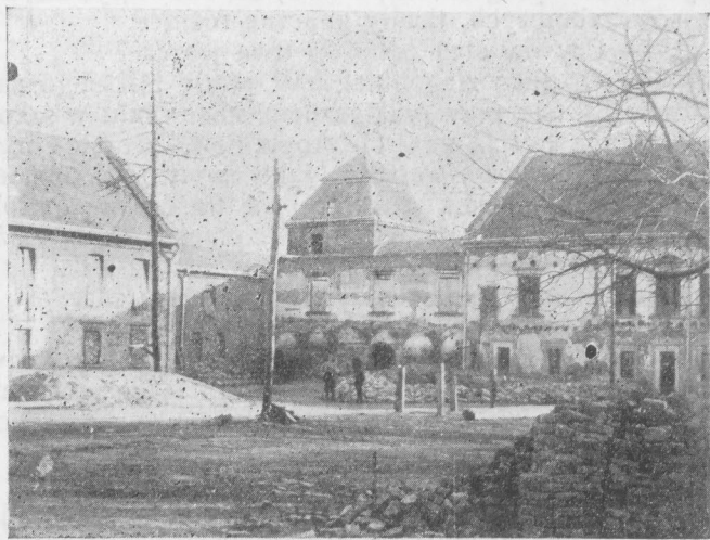
Chrzanów — odbudowa szkoły
