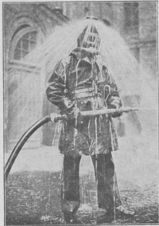
Hełm strażacki z prysznicem, pozwalający na działanie w najsilniejszym ogniu.
