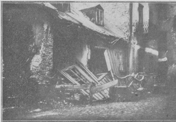
Zawalony dom przy ul. Gęsiej 87
