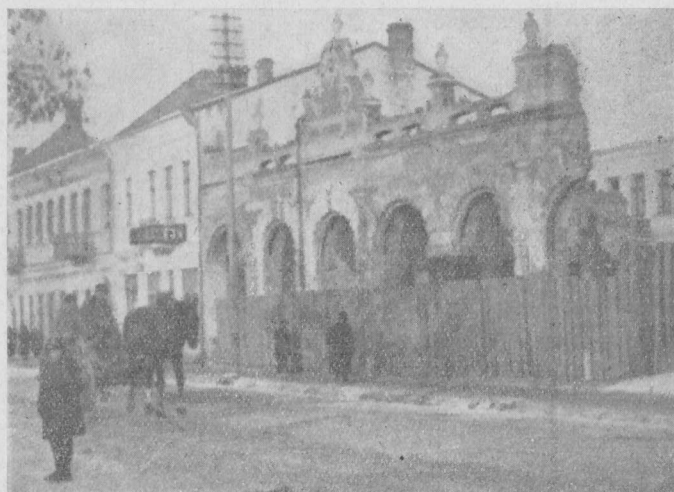
Część Brześcia, to ruiny.
