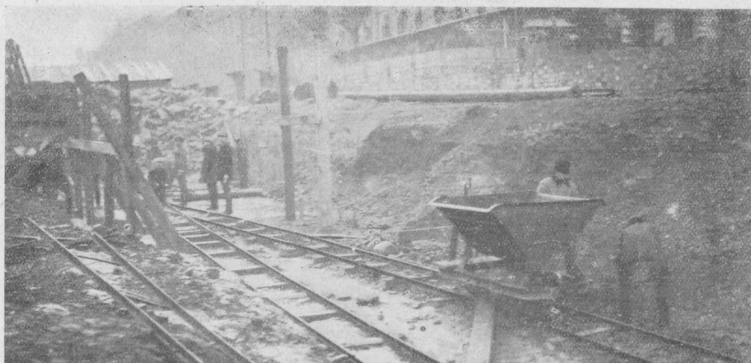
Fot. H. Vlassak. Prace nad tunelem w ul. 3 Maja. — Posuwa się więc zwolna ale stale budowa linii średnicowej, tak doniosła dla przyszłości gospodarczej naszej stolicy i całej Polski.
